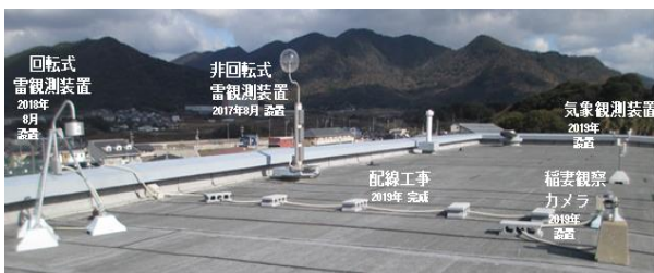
図3 屋上に設置した観測装置
