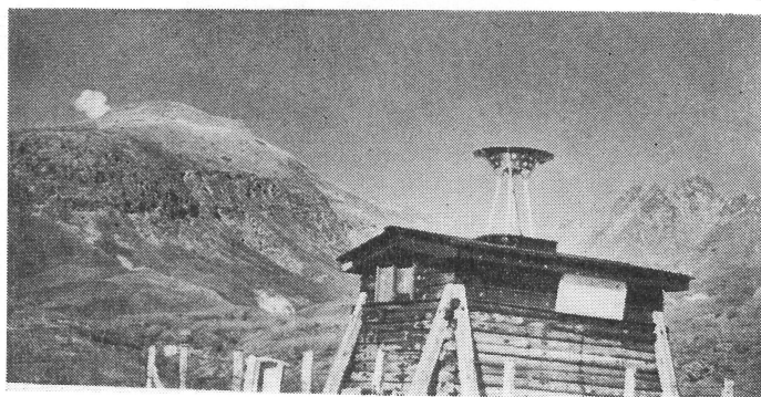
那須岳無線ロボット雨量観測所
