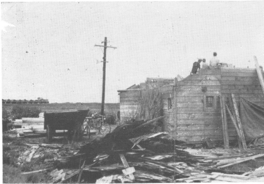
写真4 破壊された納屋（矢挽氏） つつ巻に巻揚げられた舗道車が見える 以下下田技官撮影 （6月8日）
